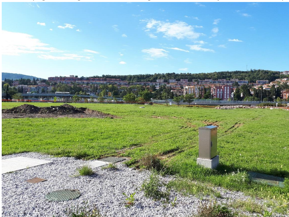
Slika: Kupi gradbenega materiala na degradiranem območju ob Semeledski promenadi
