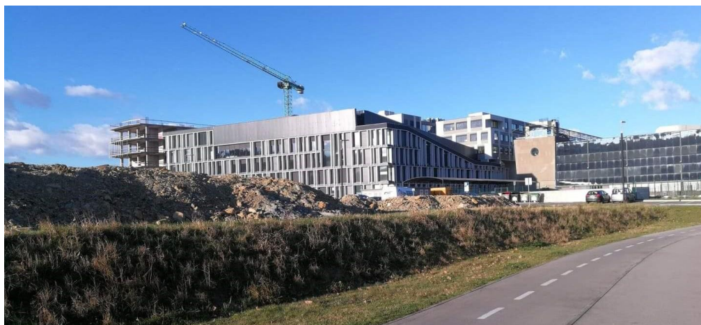
Slika: prikaz obstoječega stanja
