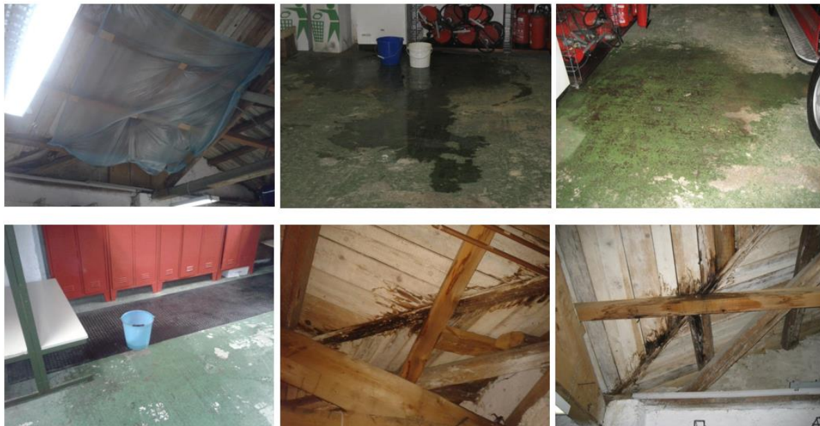
Slika 4: Znaki dotrajanja objekta - puščanje strehe
