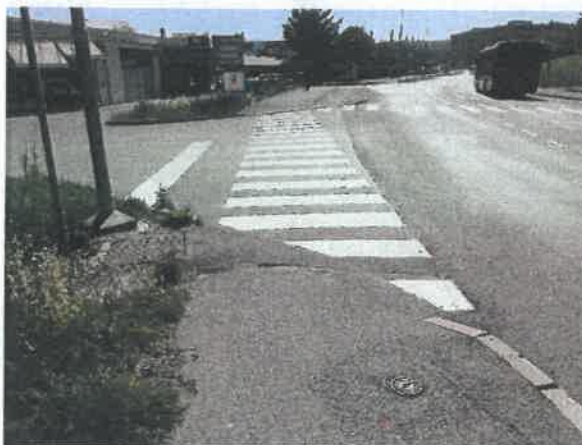
Foto 1: Navezava na kolesarsko stezo vzhodno.
