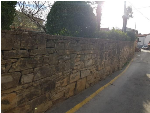
Slika 2. Obstoječi kamniti zid
