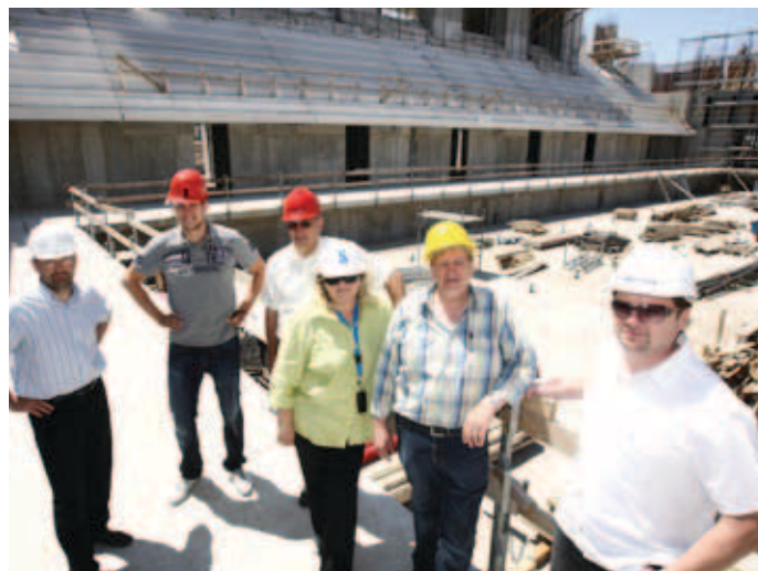
Člani komisije za spremljanje gradnje bazenskega kompleksa so konec maja preverili stanje na terenu.
