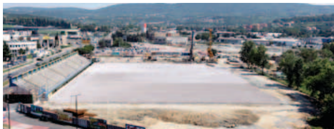
Na Bonifiki potekajo obsežna in zahtevna gradbena dela, ki so osnova za kvalitetne športne površine in spremljajoči objekt, ki bo zagotavljal dobro podporo tako za treninge kot tudi za tekmovanja.
