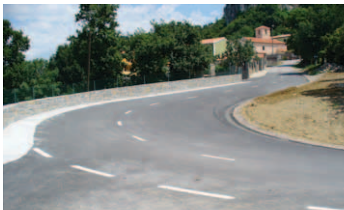
Na Socerbu so končno prenovili odsek ceste.
