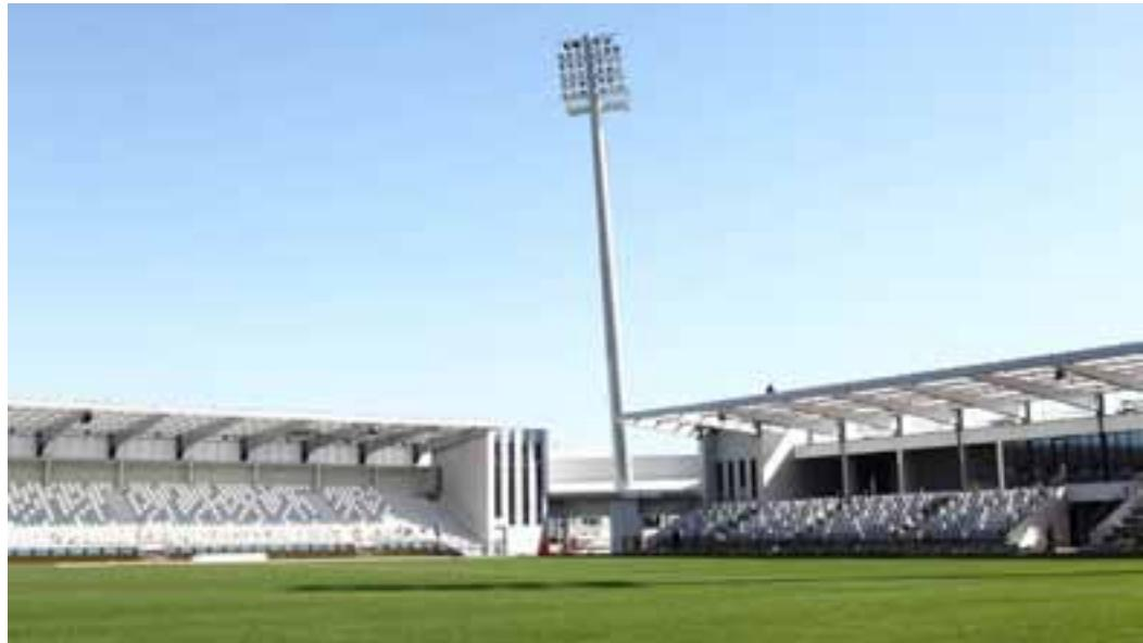
*Nogometno igrišče razsvetljuje 136 reflektorjev na štirih poševnih 38 m visokih stebrih. Takšna razsvetljava omogoča kvalitet TV prenos.*
