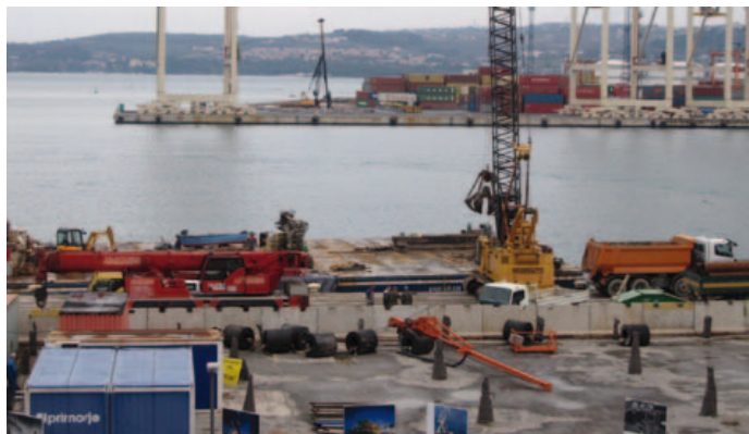
V Luki Koper so že decembra lani začeli utrjevati obalni zid in poglobljati morsko dno, s tem se bodo pripravili na prihod največjih potniških ladij za križarjenje.
