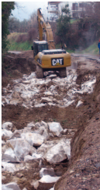
Na stari Šmarski cesti sanirajo posledice plazu. Zgradili bodo podporni zid.
