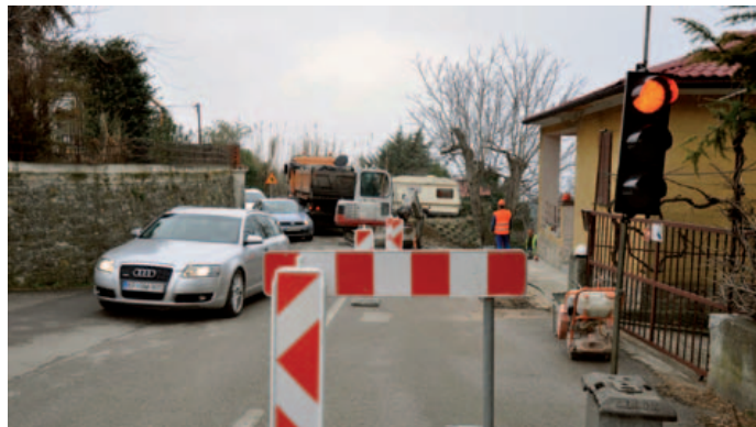
Odsek ceste ni omogočal varnega srečevanja vozil, zato so se v Mestni občini Koper odločili, da ga bodo obnovili.
