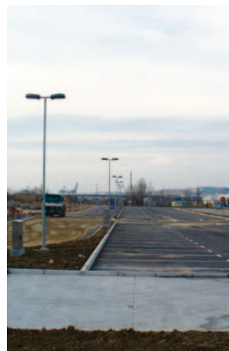
V Srminu so zgradili sekundarno komunalno infrastrukturo in začeli z gradnjo prvih hal za obrtnike.
