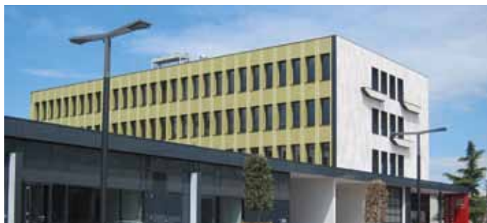
Največja prednost novozgrajenega kompleksa v Ulici 15. maja je nedvomno lastni geotermalni vir energije.
