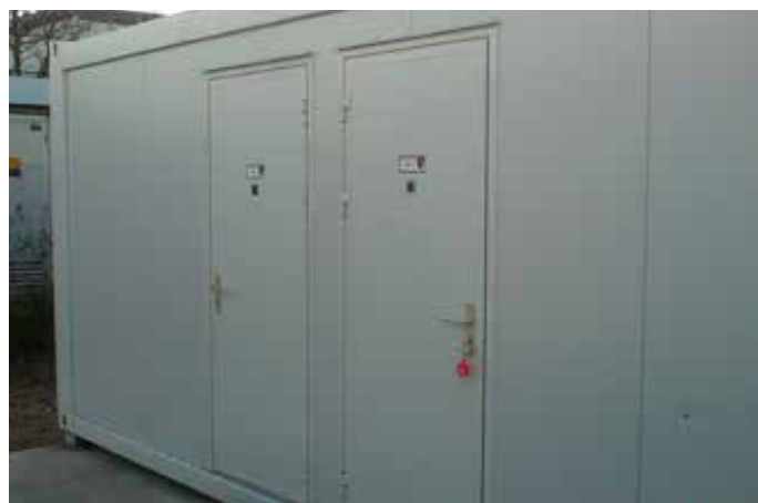
V zavetišču za brezdomce so postavili tudi sanitarni zabojnik z ločenimi stranišči za ženske in moške ter tuši s toplo vodo.
