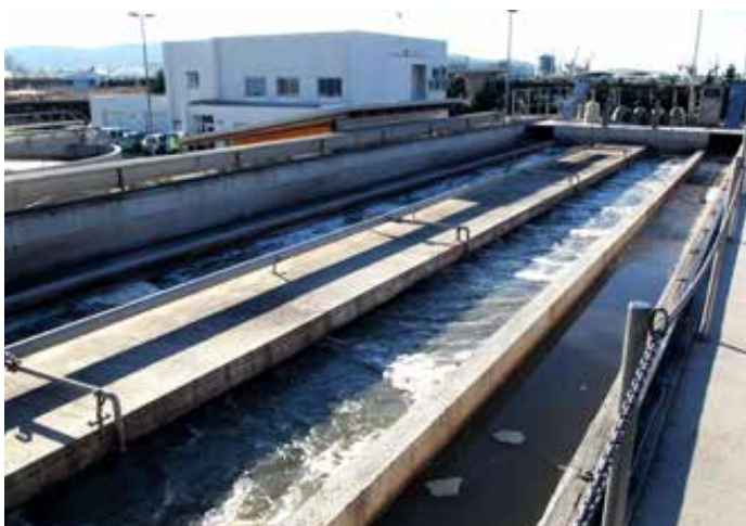
Na področju urejanja komunalne infrastrukture proračun za leto 2013 zajema tudi odpravo napak na obalnem projektu centralne čistilne naprave.
