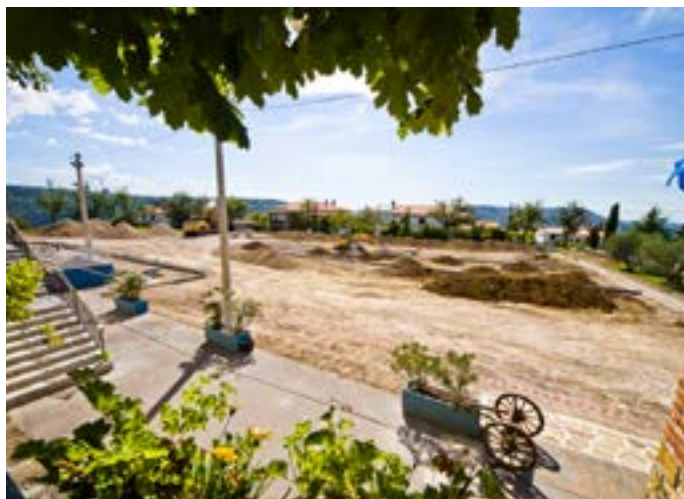
Kmalu bodo tudi uradno predali namenu na novo urejeno parkirišče pod združnim domom v Marezigah.
