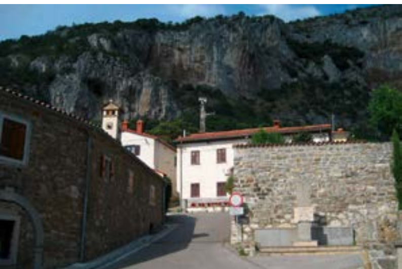
V septembru se je začela tudi sanacija skalnega podora v Bezovici.
