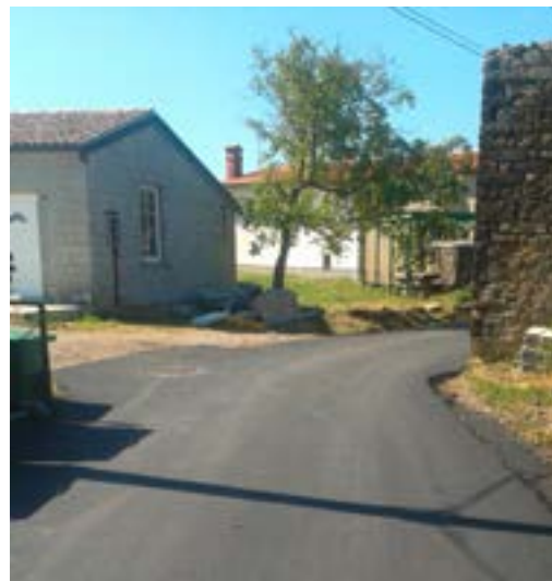
Cesta v Poletičih po sanaciji.
