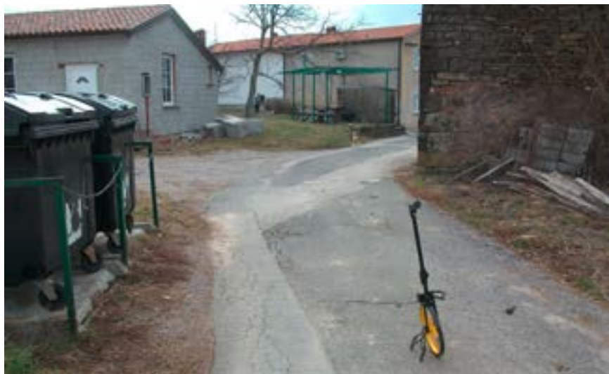
Cesta v Poletičih pred sanacijo.
