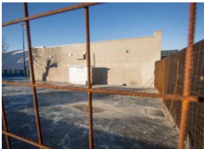
Septembra se je začela dozidava servisnega objekta v Žusterni - občina bo del prostorov namenila tudi za ureditev javnih sanitarij.
