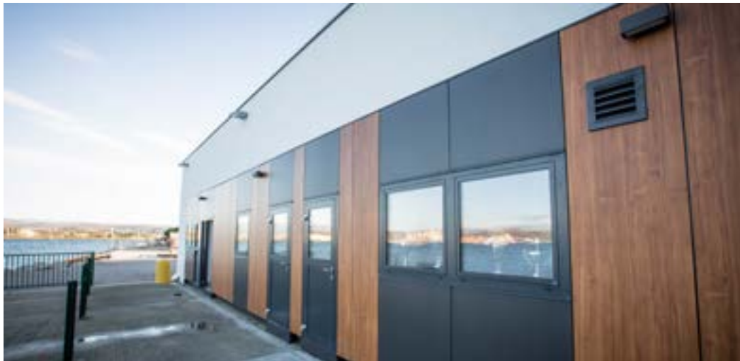
V okviru prve faze je koprška občina celovito sanirala servisni objekt ob bazenu v Žusterni.
