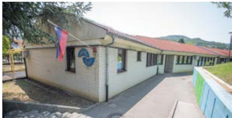
V okviru energetske sanacije vrtca v Prisojah bo občina med drugim toplotno izolirala fasado in zamenjala stavbno pohištvo.
