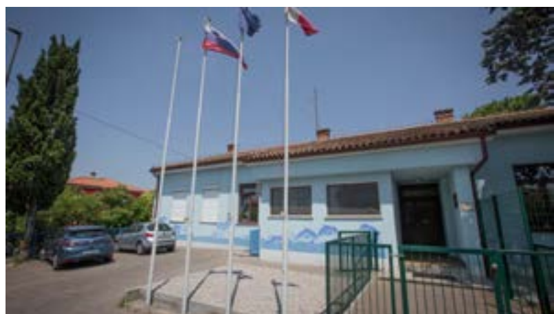
Izvajalec del, podjetje VG 5 d.o.o., bo energetske sanacije šole in vrtca v Bertokih zaključil do začetka prihodnjega šolskega leta.
