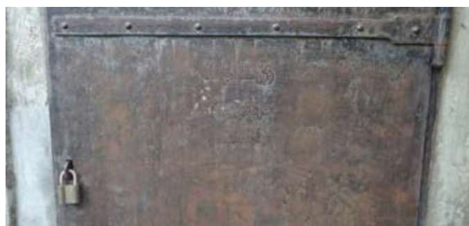
Ohranjen vhod v stari avstrijski vodni zbiralnik in pogled v njegovo notranjost. Na originalnih vratih je še dobro vidna letnica gradnje 1913.
