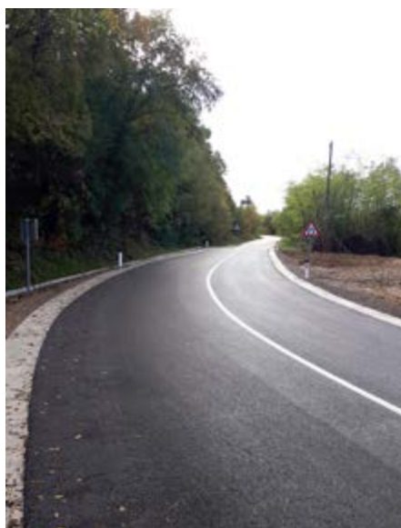
Občina bo letos nadaljevala z obnovo ceste od Šmarij proti Pučam.
