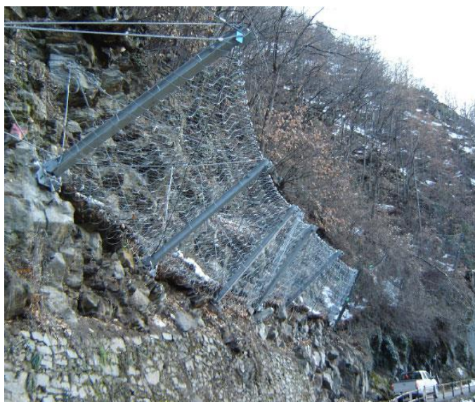
Slika 12: Shematski prikaz podajno lovilnih ograj nosilnosti 2000 kJ
