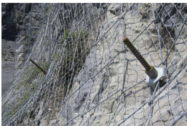
Slika 13: Shematski prikaz sidranega sistema nosilne vrvne mreže
