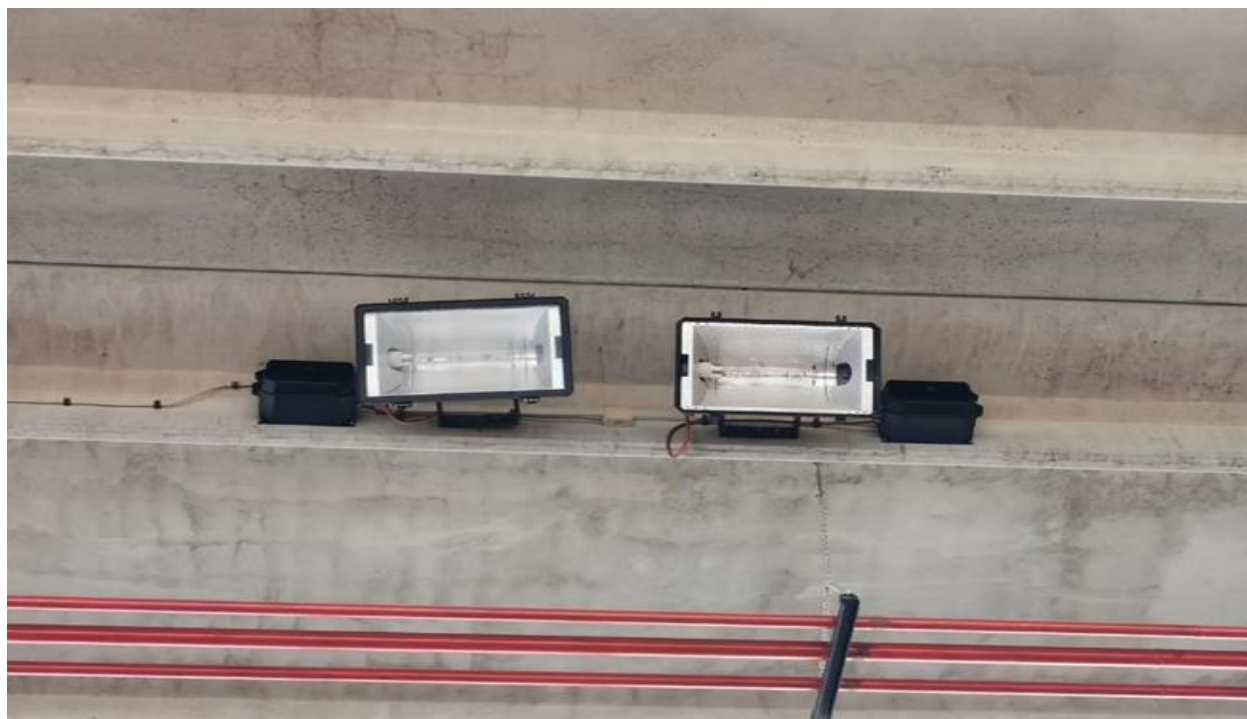
Slika 7: Halogenski reflektorji (Vir: REP Matjaž Filipčič s.p., november 2021)
