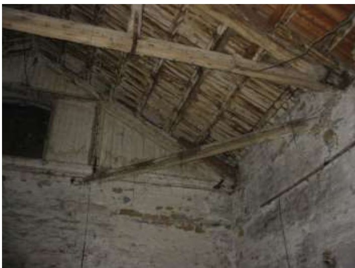
Slika 2: Obstoječe stanje objekta – pogled v notranjost
