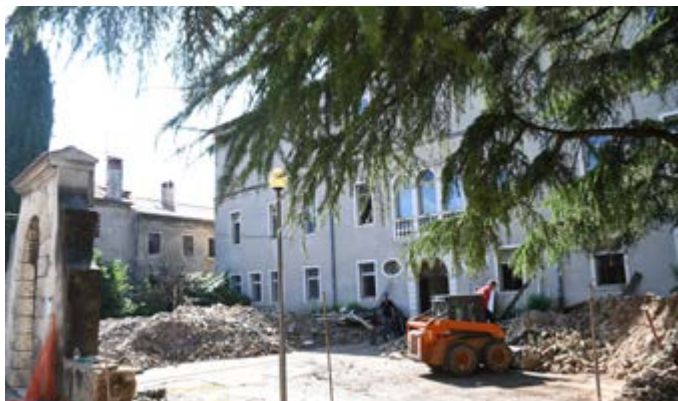
Pri prenovi šole Collegio dei Nobili gre za obsežno in nadvse zahtevno prenovu.
