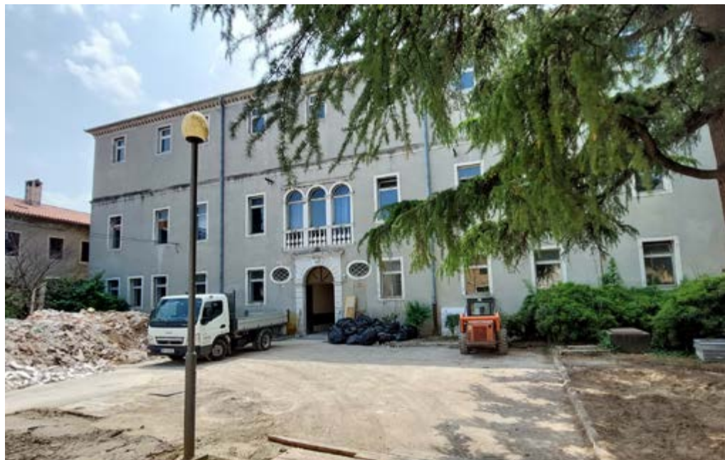
I lavori in corso al Collegio dei Nobili a Capodistria.
