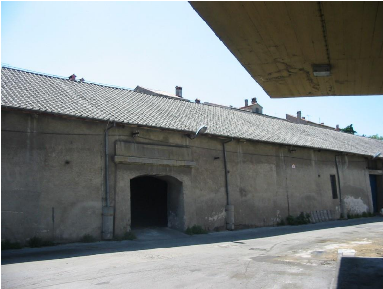
Slika 4: Obstoječe stanje objekta – zunanji izgled
