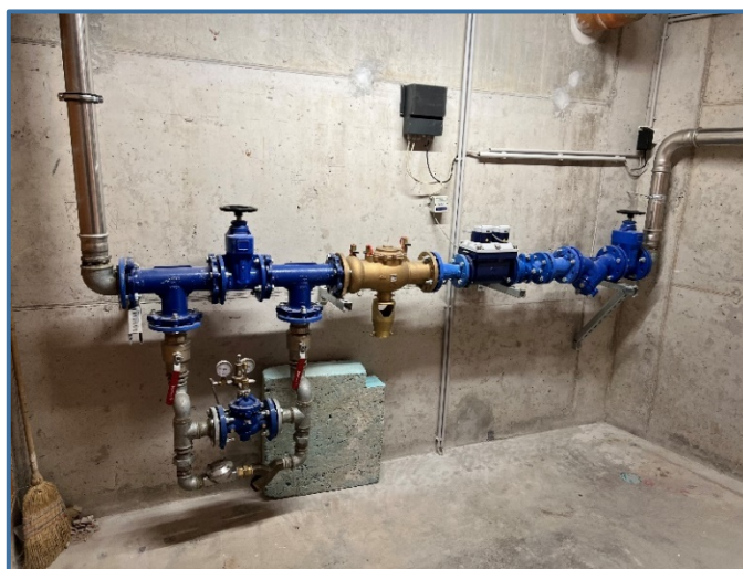
Slika 5: Sklop vodomera požarne vode
