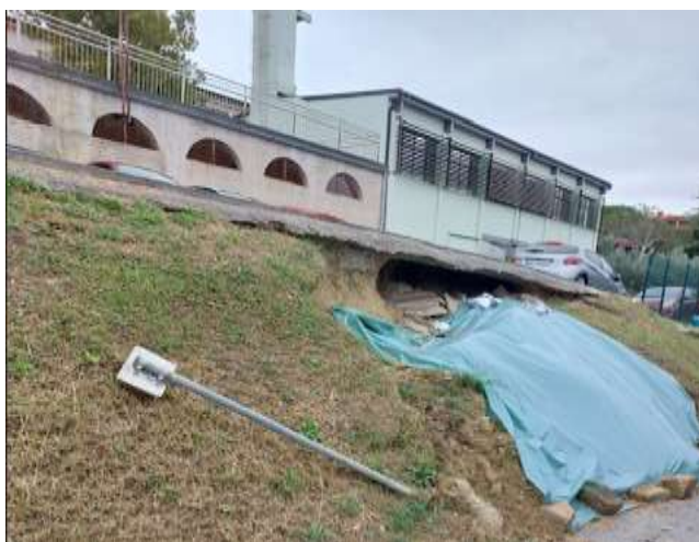
Slika 4.1, Slika 4.2 – Plazenje na območju predvidenega posega novogradnje
