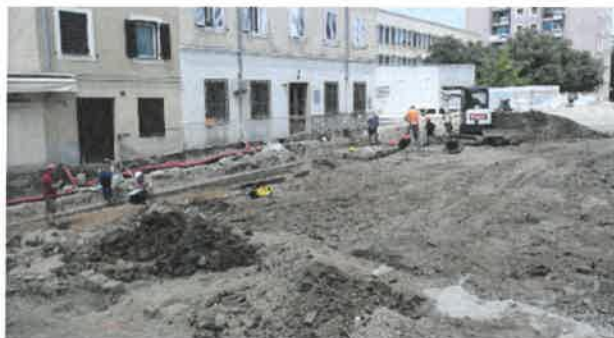
Fotografiji 13 in 14: izkop zgornjih plasti
