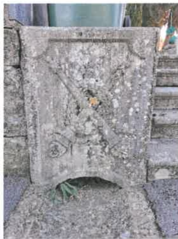
Detajl odvodnjavanja
