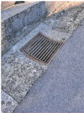
Ureditev odvodnjavanja ob osrednji komunikacijski osi pokopališča
