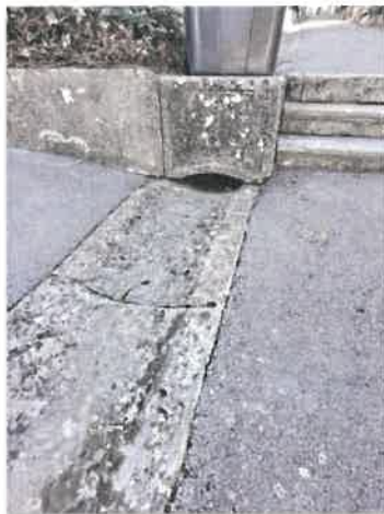
Ureditev odvodnjavanja ob osrednji komunikacijski osi pokopališča
