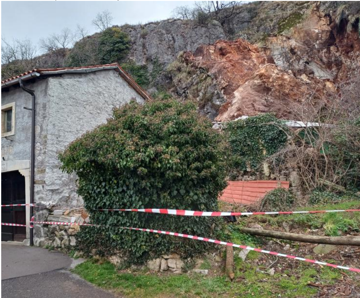
Slika 2: Skalni podor na območju 1
